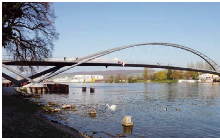
Beste Verbindungen im Dreiländereck: Die Fussgänger- und Velobrücke zwischen Weil am Rhein und Huningue.
