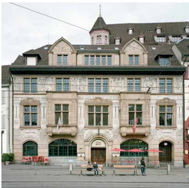
Der Braune Mutz am Barfüsserplatz 10. Die Fassade des imposanten, 1913 von Rudolf Sandreuter für die Brauerei Feldschlösschen errichteten Gebäudes ist von fantasievollen Sgraffito-Dekorationen des Basler Malers Franz Baur geprägt.
