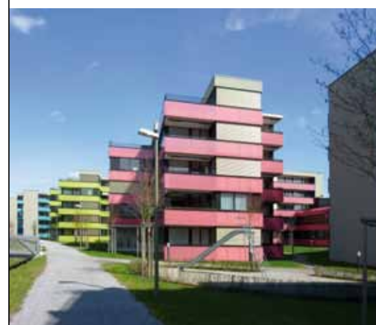
Siedlung Talwiesen, Winterthur, 2008-2010. Fünfgeschossige Punktbauten.
