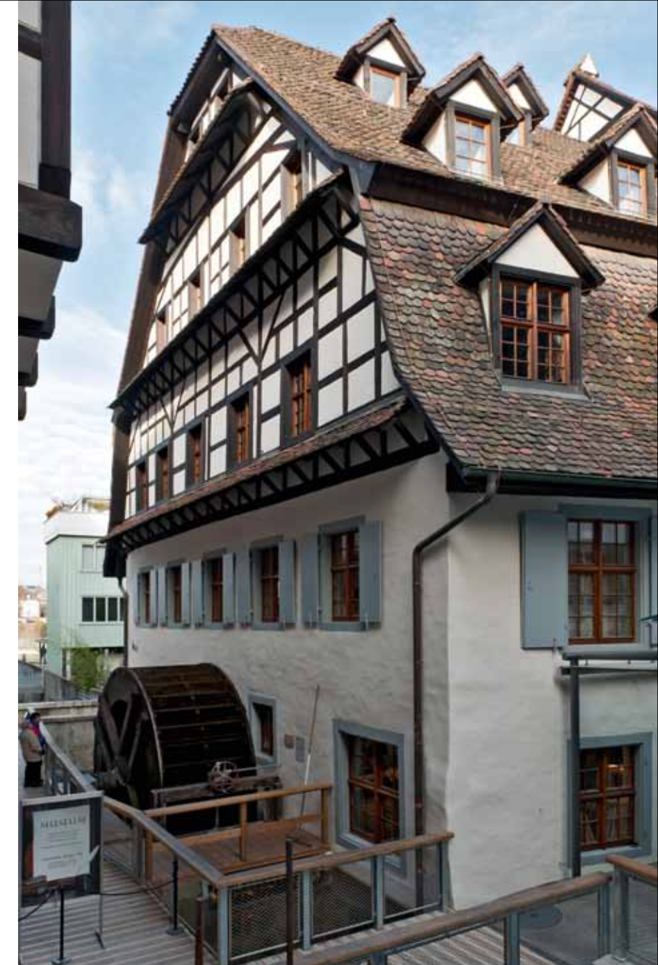
Die renovierte Gallizianmühle/Basler Papiermühle. Links der neue Zugang über einen Holzsteg entlang der Stegreifmühle, rechts der neu überdachte Innenhof zwischen Gallizianmühle und Rychmühle.
