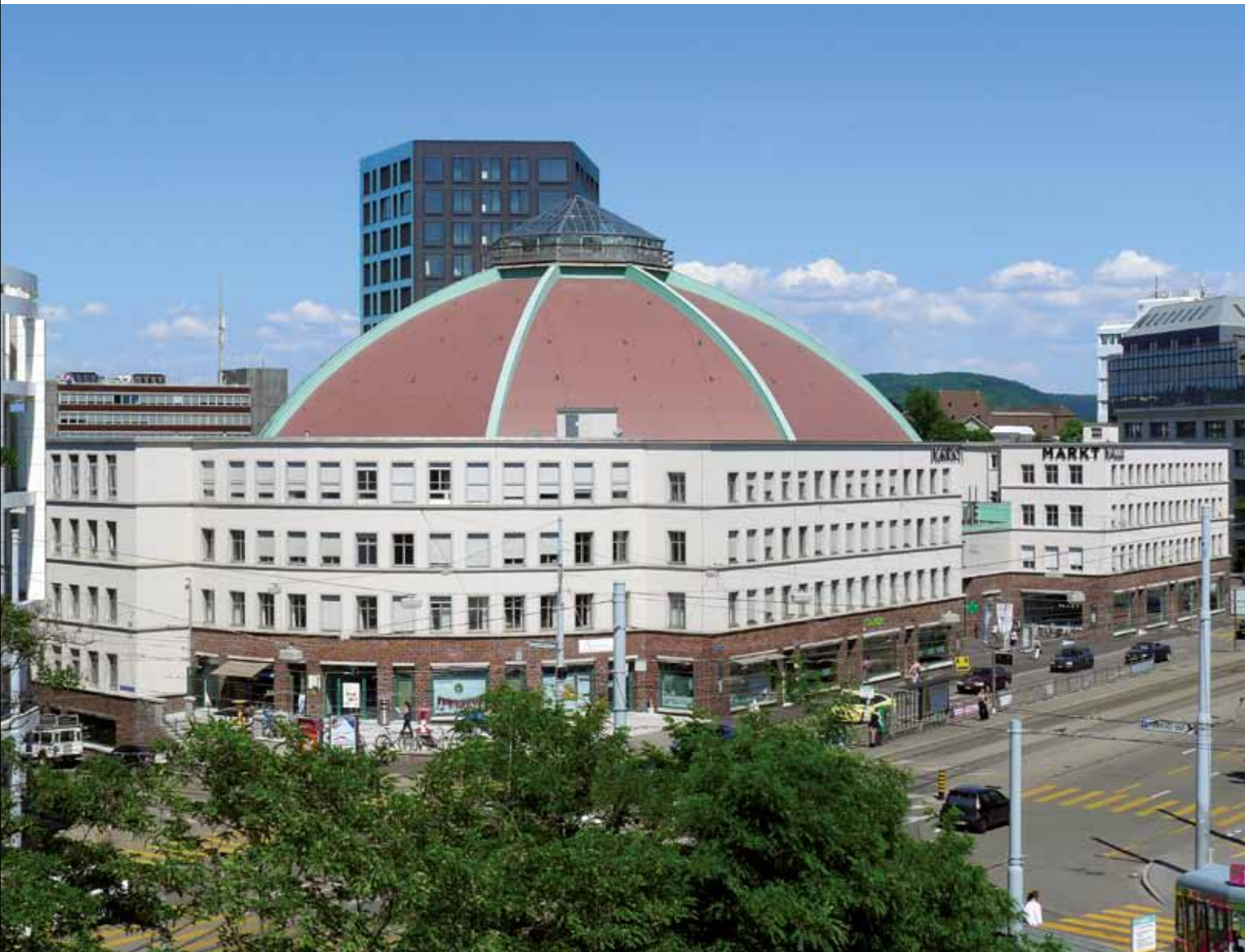
Der Gebäudekomplex der Markthalle nach der Restaurierung und Erweiterung. Im Vordergrund die beiden Kopfbauten gegen die Viaduktstrasse/Innere Margarethenstrasse, die die zentrale Kuppelhalle spangennartig umfassen. Der 1973 ergänzte Trakt vor dem zentralen Haupteingang ist im Zug des Umbaus wieder entfernt worden. Im Hintergrund das neue Wohnhochhaus von Diener & Diener Architekten.
