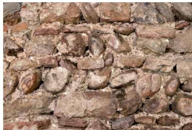
Mauerwerk aus dem 13. Jahrhundert im hinteren Bereich des Hauses Spalenberg 59.
