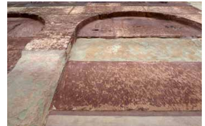
Blendbogenpartie am Georgsturm mit tonhaltigem Molasse-Sandstein.
