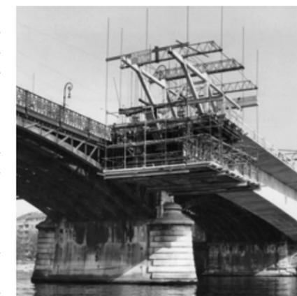
den Brückenhälften links und rechts der alten Brücke errichtet, dann die alte Brücke abgerissen und schliesslich die beiden Hälften aneinandergeschoben. Die Führung beleuchtet – samt Augenschein in einem der Hohlkastenträger – die konstruktionstechnischen Prinzipien und die spannende Baumsetzung.
