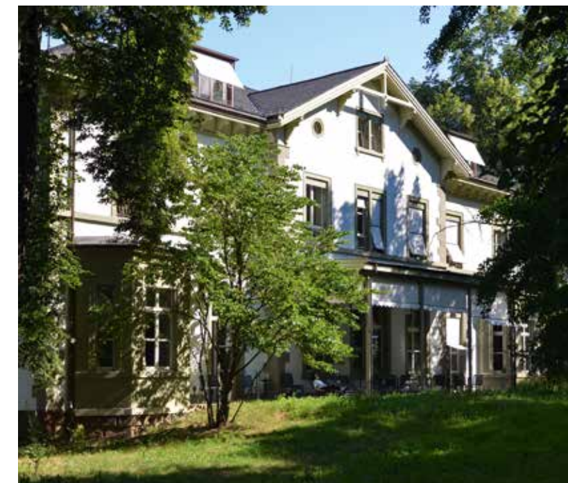
Das Haus B wird wie auch andere Elemente der Anlage durch schwach geneigte Dächer, übergebeltete Risalite, vortretende Loggien und zurückhaltende Detailformen geprägt.
