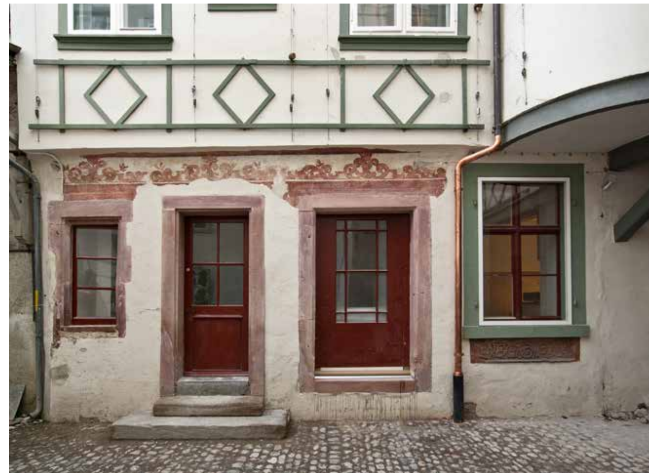
Konservierte Fassadenmalerei aus dem 17. Jahrhundert an der zur Hofeinfahrt gekehrten Seite des Südflügels [B] . Die symmetrisch angeordneten Ranken- und Rollwerkformen wurden bereits in den 1980er Jahren entdeckt und teilweise freigelegt.
