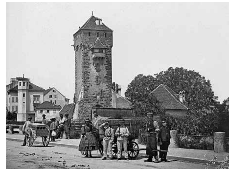
Feldseitige Ansicht des St. Alban-Tors. Foto um 1870.
