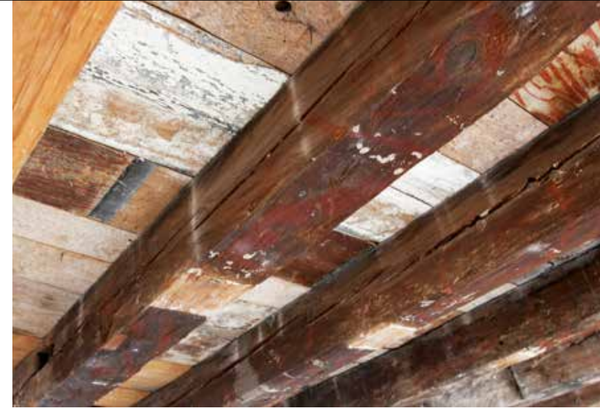
Hinterhaus von 1524. Balkenlage über dem 1. Obergeschoss. Die Balken wurden beim Schulbau um 1588 bemalt und im 19./20. Jahrhundert verändert.
