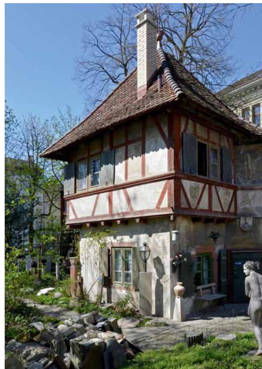
Das Wettstein-Häuschen nach den Instandsetzungsarbeiten: Die Eingriffe beschränkten sich aufs Nötigste, sodass die charakteristischen Spuren der Zeit bewahrt werden konnten. Neu aufgemauert wurde der Schornstein.
