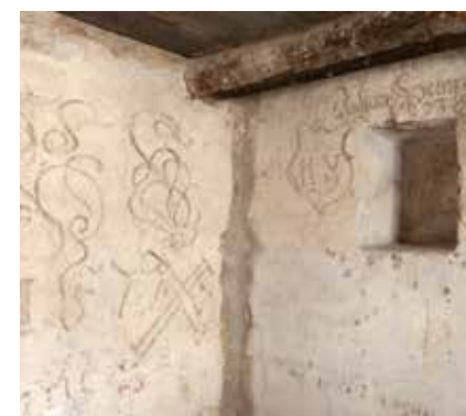
Stube im 4. Obergeschoss des Hauses zum Luchs mit Nische und Wandmalereien: Handwerksinsignien, Ornamente und Wappenkartuschen sowie Namen und Initialen der Schuhmacher-Familie Vögelin von 1673 bis 1677. Foto 2014.
