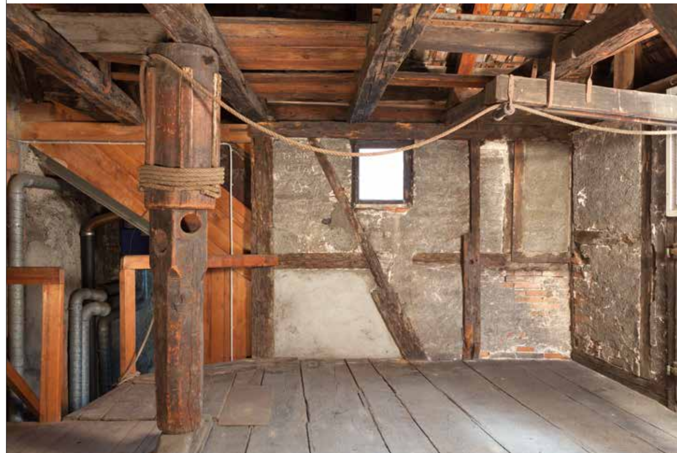
Aufstockung über der rechten Hälfte des Hauses zur Neuen Brücke von 1784 mit Luke und Aufzugsvorrichtung. Foto 2014.
