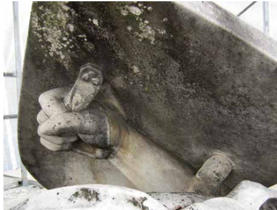
Vor Beginn der Konservierungsarbeiten: Schmutzkrusten, Algenbewuchs, Niederschlag von Flugrost, Oberleitungsabrieb und Automobilemissionen, Relikte von früheren Reinigungsaktionen sowie andere Störfaktoren ergaben keine «schöne» Alterspatina, sondern ein überaus tristes Bild.
