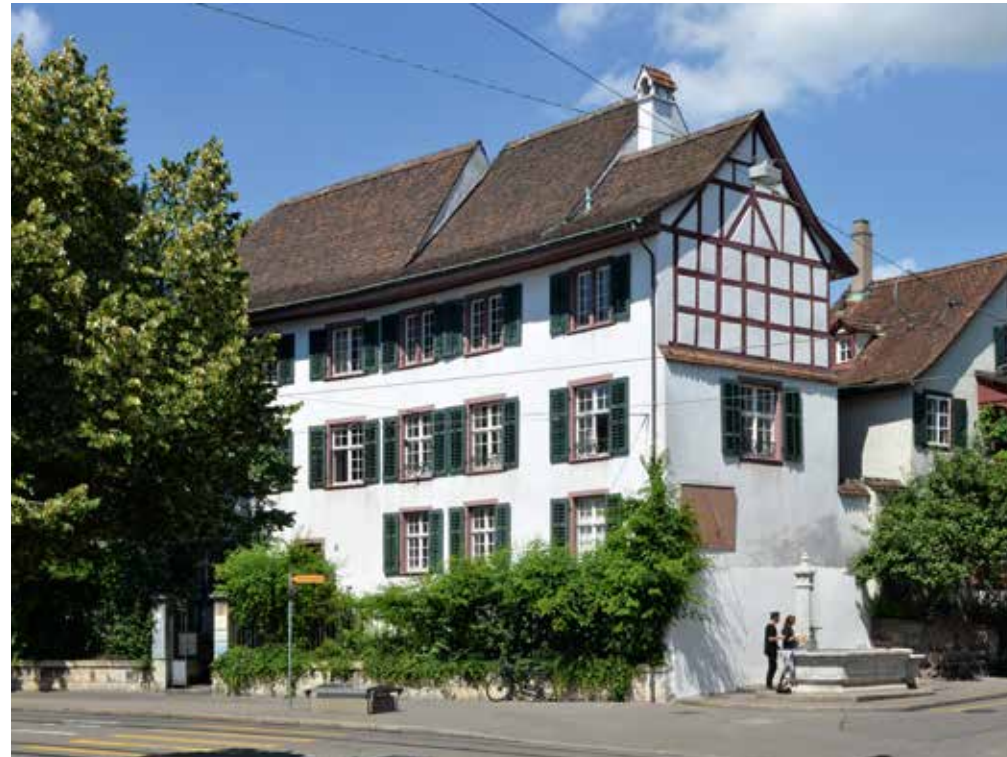
Leonhardsgraben 63, ehemals Pfarrhaus zum Ölenberg. Die verschieden geneigten Dächer markieren die einstige Unterteilung in drei separate Gebäude; auch die zwar axiale, aber ungleich verteilte Fensteranordnung weist auf drei verschiedenen Baukörper hin.
