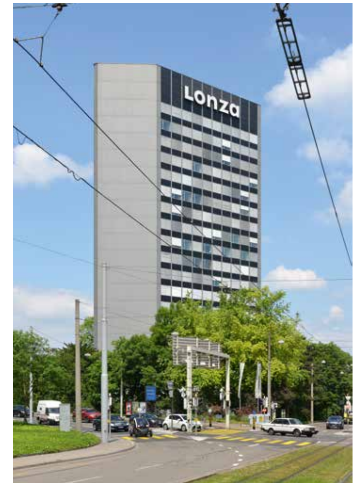
Gio Pontis «Forma finita» auf robuste Schweizer Verhältnisse heruntergebrochen: Suter + Suter, Bürohochhaus Lonza, Münchensteinerstrasse 38, 1960–1962.
